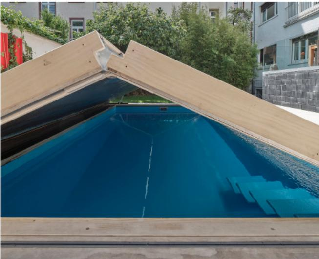
Ein echter Clou ist das klappbare Holzdeck als Poolabdeckung. Es öffnet sich wie eine Schiffsbrücke. Aufgrund des geringen Platzes war nur diese Lösung möglich.
